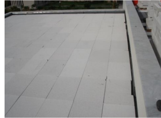
Çatı ve Teras Yalıtımı
