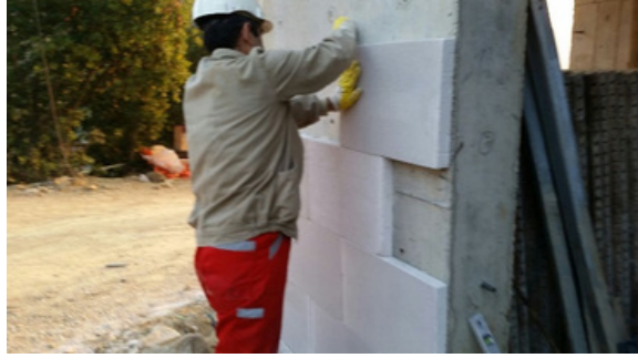
Kolon ve Kiriş Yalıtımı
